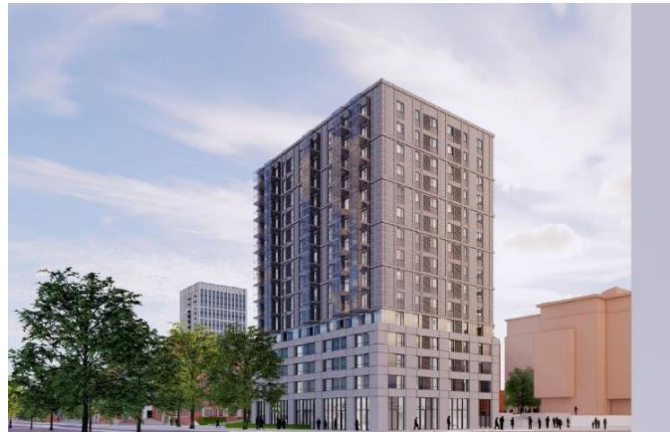
Nieuwbouwproject 'Elara' (bron: Staedion)
