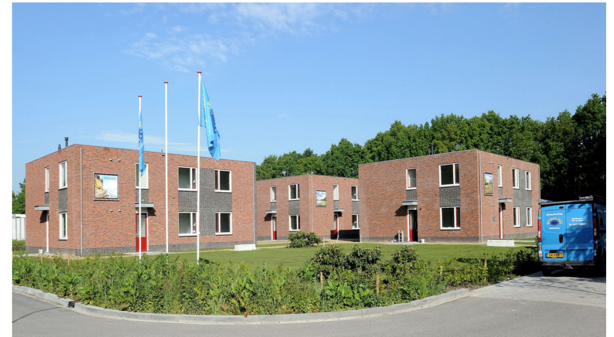
Flex Logies Gebouw in Eersel
